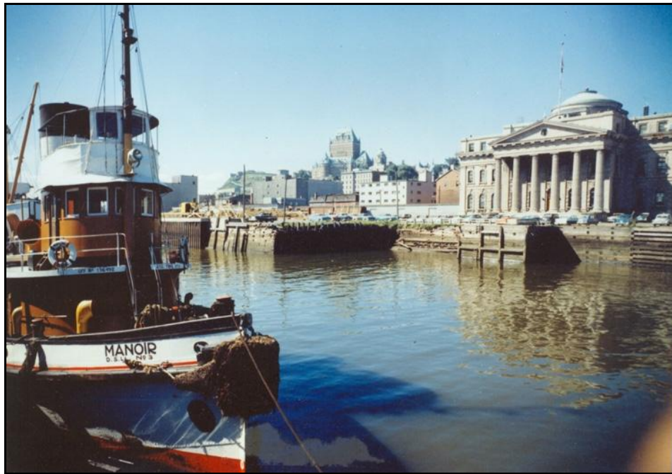
Québec : le bassin de la Douane récemment remblayé.
